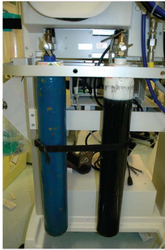
(β) Κύλινδροι αερίων στην πίσω πλευρά του μηχανήματος αναισθησίας (N 2 O αριστερά, O 2 δεξιά)
